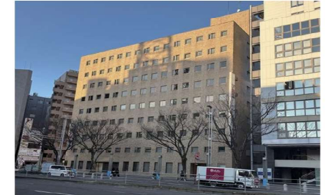
朝日生命千葉ビル
