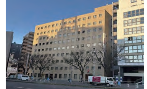
朝日生命千葉ビル
