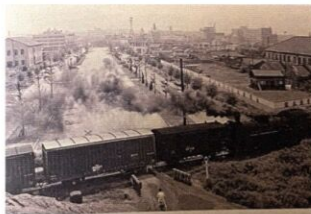
1960年頃の駅前大通り（造成中）
